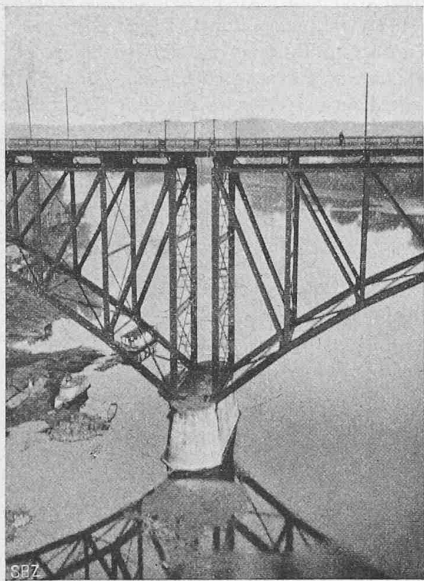
Abb. 64. Mitteljoche auf dem Stropfweiler der Fort Snelling-Brücke.
