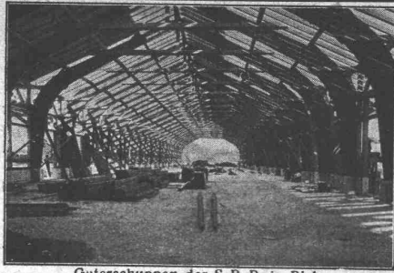
Gutschuppen der S. B. B. in Biel.
