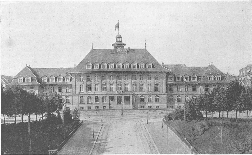
OBEN: HAUPTANSICHT IN DER AXE DER KORNHAUSSTRASSE
