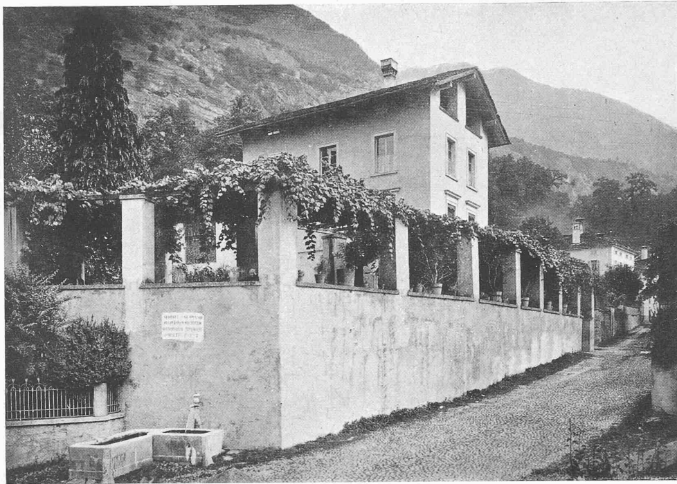
OBEN: ANSICHT VON SÜDEN, TALAUFWÄRTS
