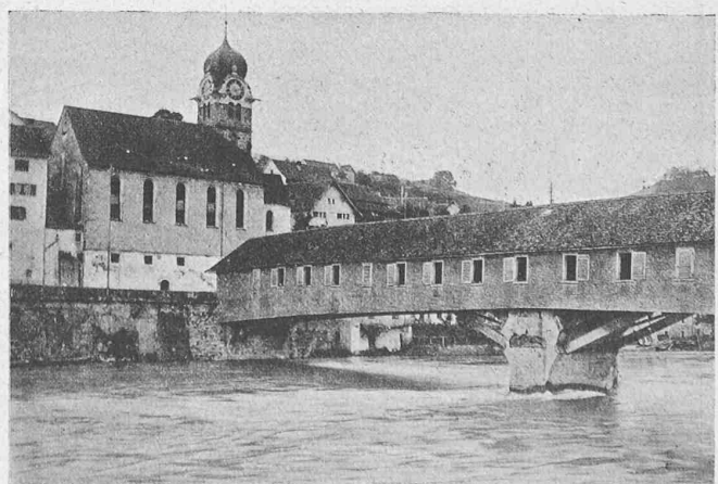
Abb. 2. Die 1811 erbaute Holzbrücke in Eglisau, vom linken Ufer aus.
