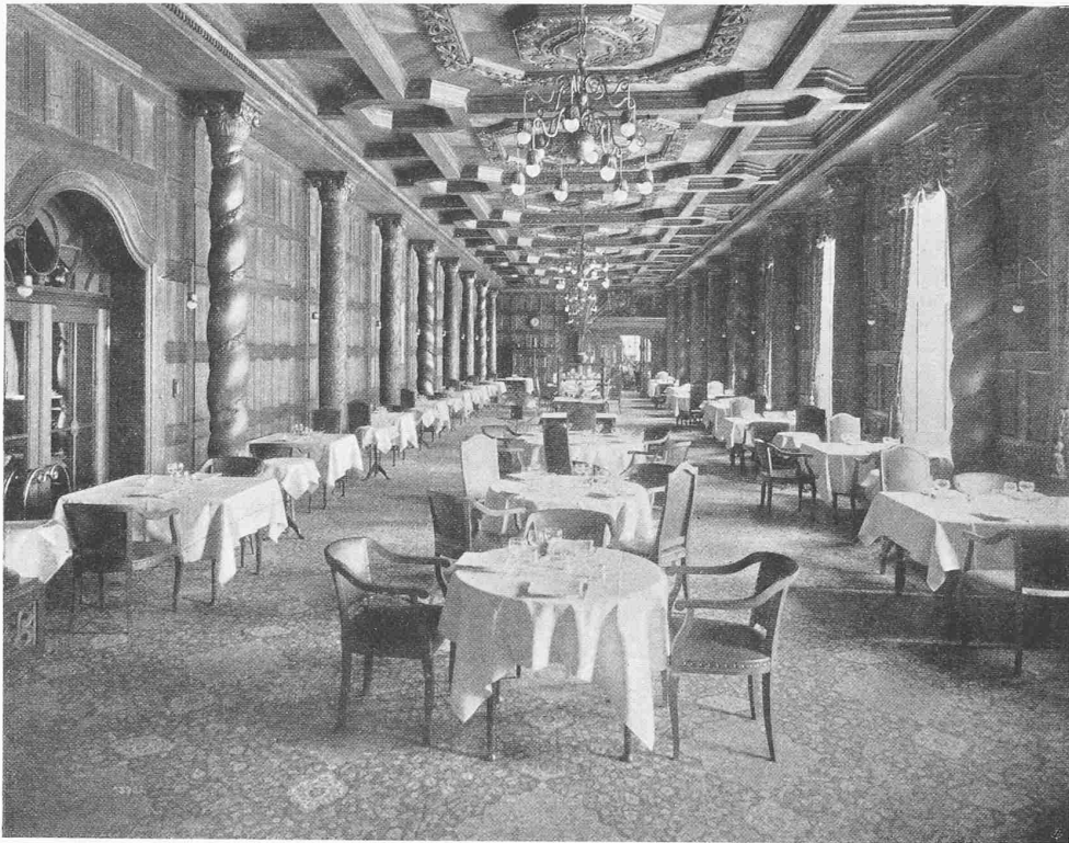
AUS DEM VON ARCH. K. KOLLER ERBAUTEN „SUVRETTAHAUS“
