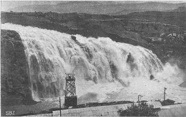
Abb. 21. Ueberlauf-Absturz ins Unterwasser. am 26. Mai 1916.
