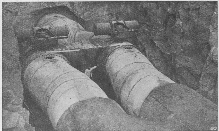
Abb. 34. Fertig montierte Gabelung der Druckleitung, vor der Einbetonierung.
