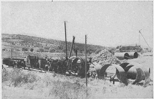
Abb. 37. Im Werk vernietete Rohrschüsse auf der Baustelle.
