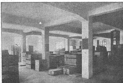
Geschäfts- und Lagerhaus von Huber & Ziegler und Huber & Cie. in Zürich 5, Limmatstrasse.
