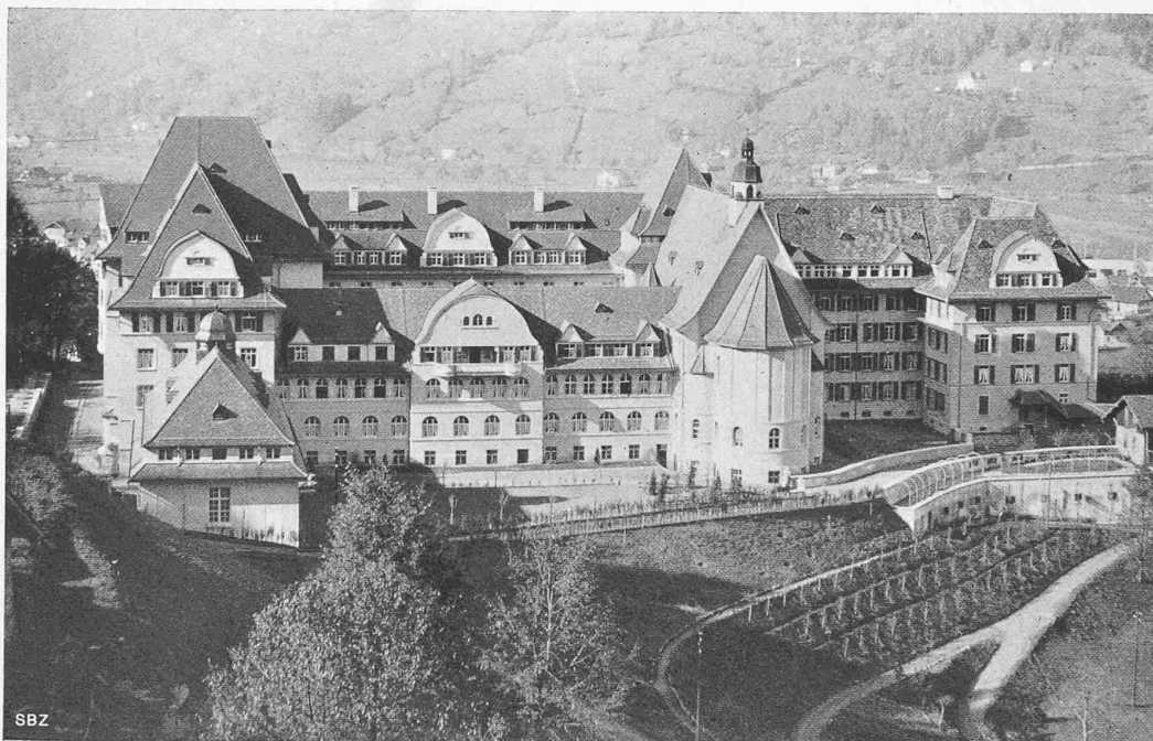
OBEN GESAMTANSICHT VON OSTEN
