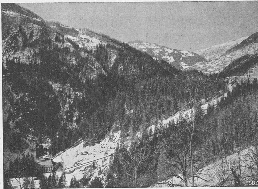
Abb. 23. Uebersicht talauswärts der untern, offen verlegten Druckleitungsstrecke.
