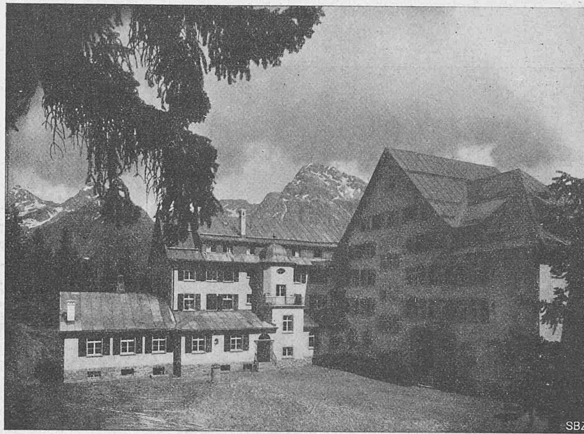
Abb. 3. Hofansicht aus Nordwest im Sommer.
