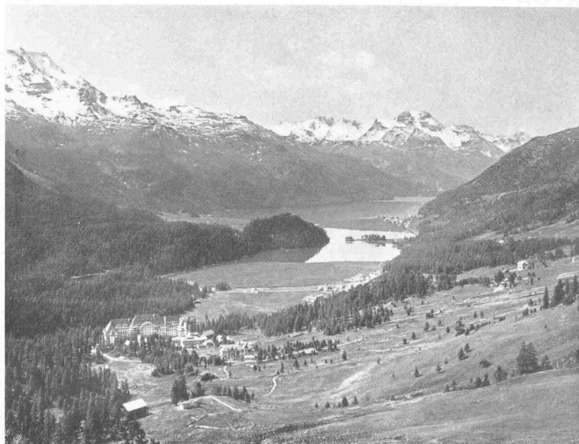
OBEN: ANSICHT DES HOTELS VON SÜDOSTEN, IM WINTER DARUNTER: BLICK AUS NORDEN ÜBER DAS HOTEL AUF DAS OBERENGADIN MIT DEM SILVAPLANER-SEE
