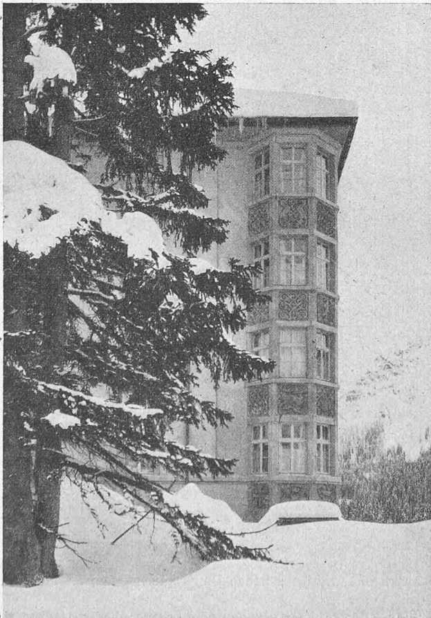
Abb. 12. Nordost-Ecke des Sanatoriums.
