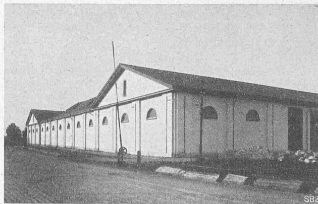
Abb. 2. Längsfront an der Münchensteinerstrasse und Rückfront.
