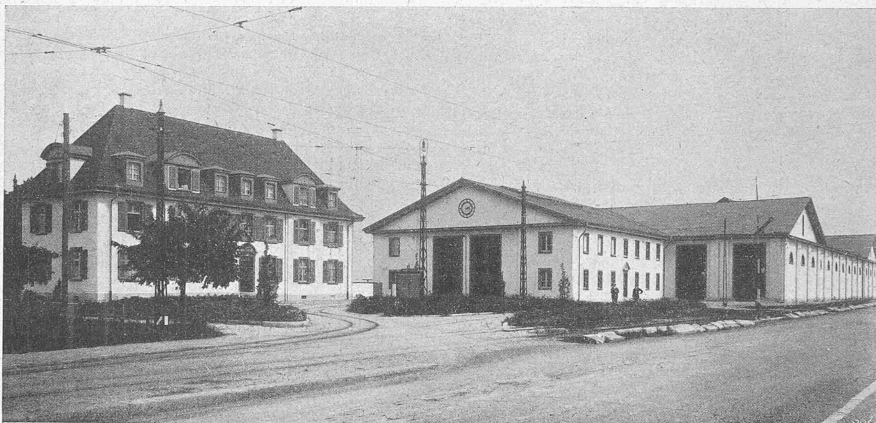
Abb. 1. Gesamtbild des Strassenbahndepot auf dem „Dreispitz“ in Basel. — Architektonische Durchbildung von Arch. H. Bernoulli, Basel.
