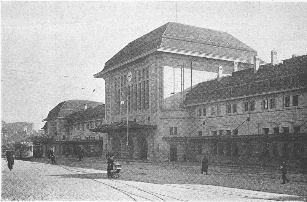
DAS NEUE BAHNHOFGEBÄUDE DER S. B. B. IN LAUSANNE
