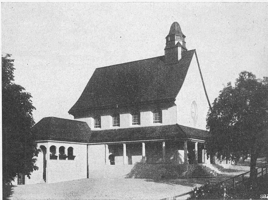
Abb. 3. Friedhofskapelle in Herisau. — Architekt A. Ramseyer in Luzern.
