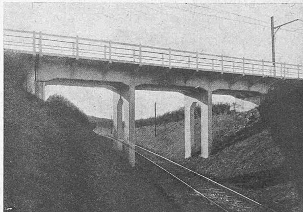
Abb. 24. Ueberführung der E. S. B. über die Emmentalbahn.
