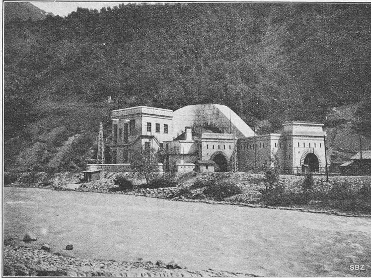
Abb. 1. Ansicht der Ventilations-Anlage am Simplon-Tunnel (Nordseite).
