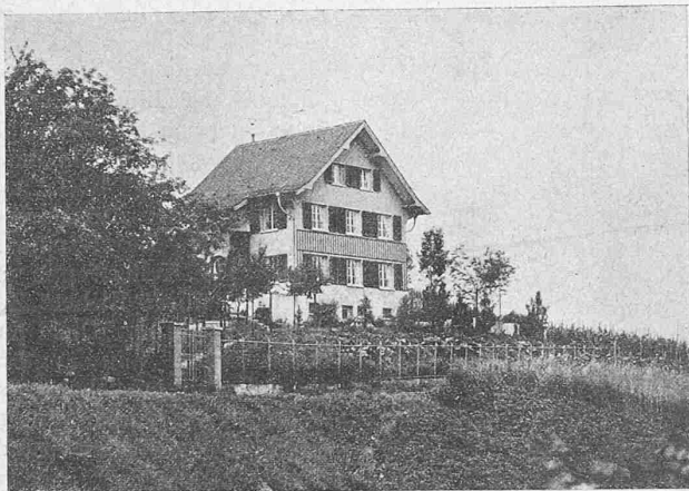
Abb. 9. Gesamtbild aus Südost.
