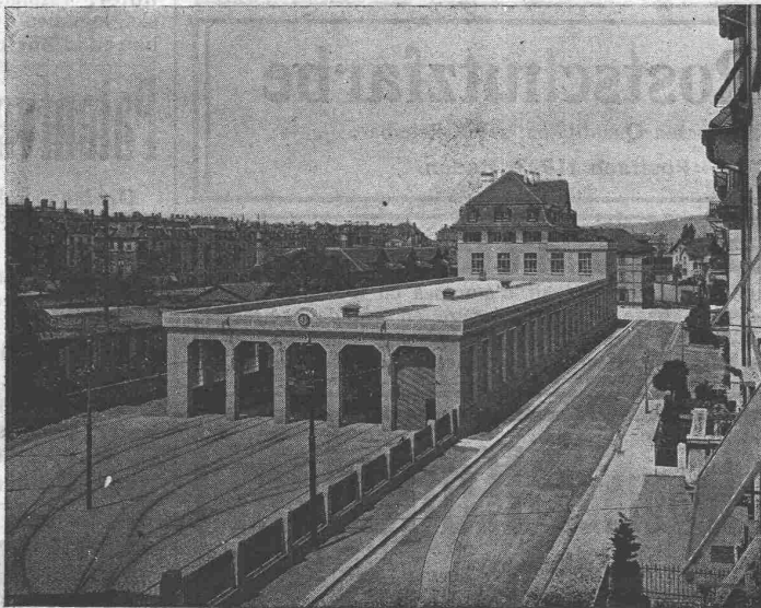
Tramremise Elisabethenstrasse Zürich, erbaut 1914.
