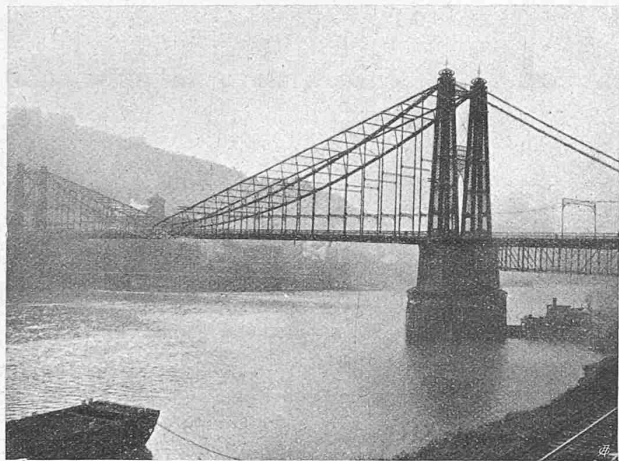
Abb. 4. Steife Hängebrücke über den Monongahela in Pittsburg.
