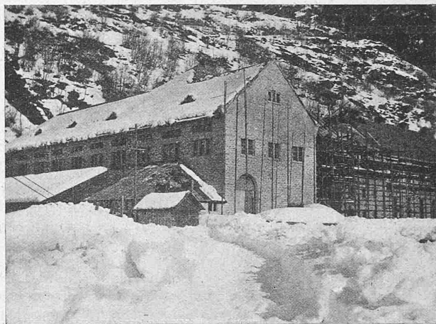
Abb. 7. Das Maschinenhaus des Kraftwerkes Ritom (31. Januar 1919).
