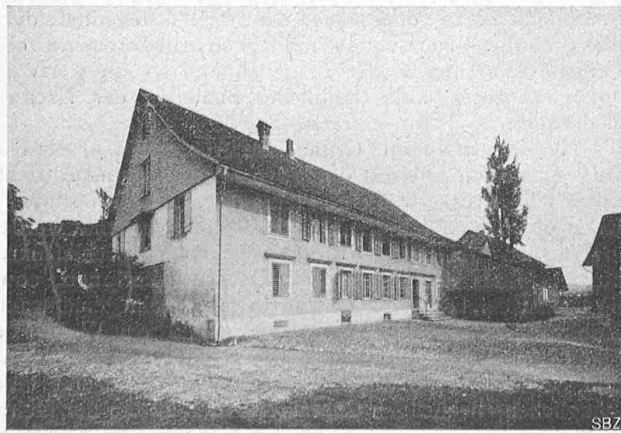
Abb. 8. Mittlere Mühle in Oberwinterthur, erbaut um 1826.
