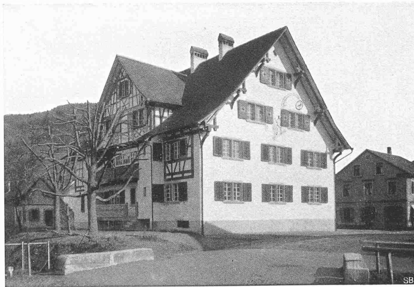
ALTES GASTHAUS ZUM „HIRSCHEN“ IN HUTZIKON-TURBENTHAL WIEDERHERGESTELLT UND INNERLICH UMGEBAUT DURCH ARCHITEKTEN FRITSCHI & ZANGERL, WINTERTHUR
