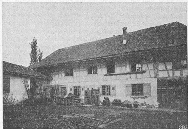
Abb. 9. Mittlere Mühle in Oberwinterthur, Rückseite (Ostseite).
