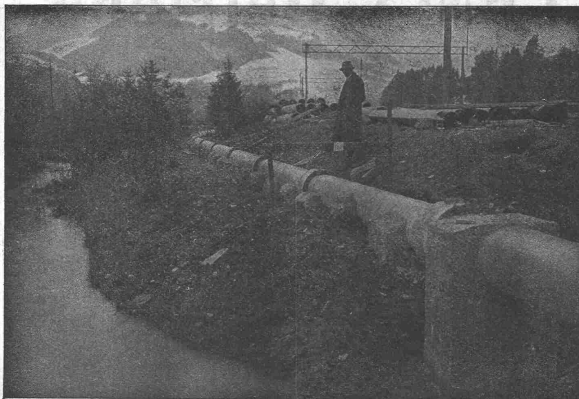
Wasserleitung der neuen Pulverfabrik in Wimmis, aus armierten Siegwart-Röhren von 400 mm Durchmesser.
