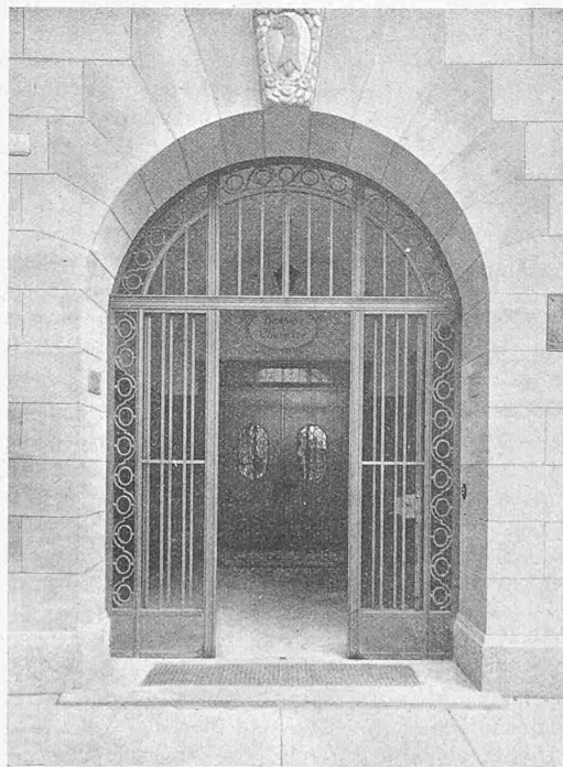
Abb. 5. Eingang zu Post und Laboratorium.
