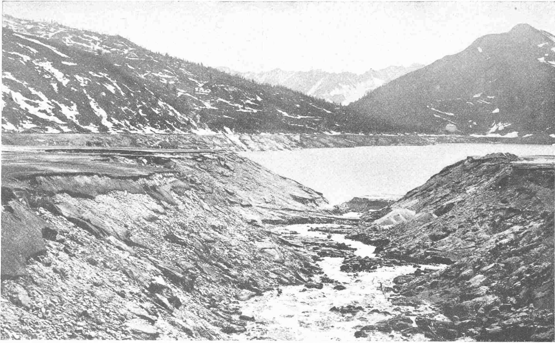
Abb. 6. Einfressen des Tomsee-Abflusses bei seiner Mündung in den Ritom-See (östlich von Punkt B in Abb. 2), 9 Monate nach Absenkung.
