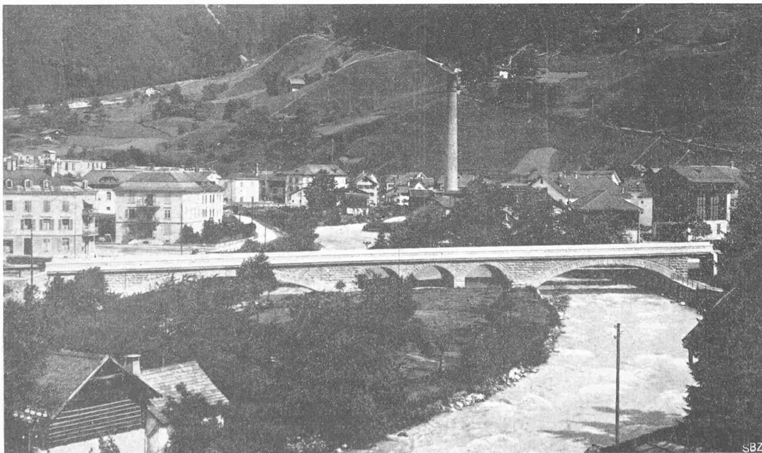
Abb. 4. Die neue Eisenbahnbrücke der S. B. B. bei Schwanden, aus Nordwesten gesehen.
