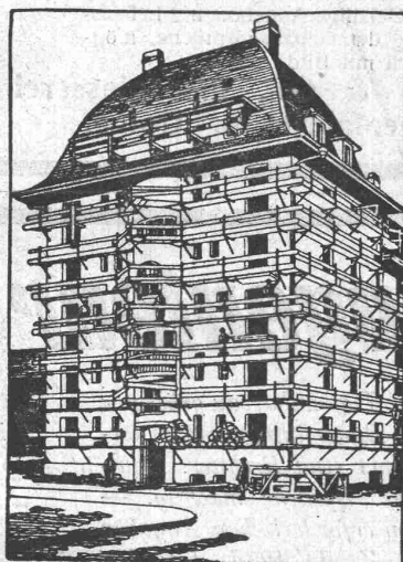
Ansicht eines eingerüsteten Hauses
