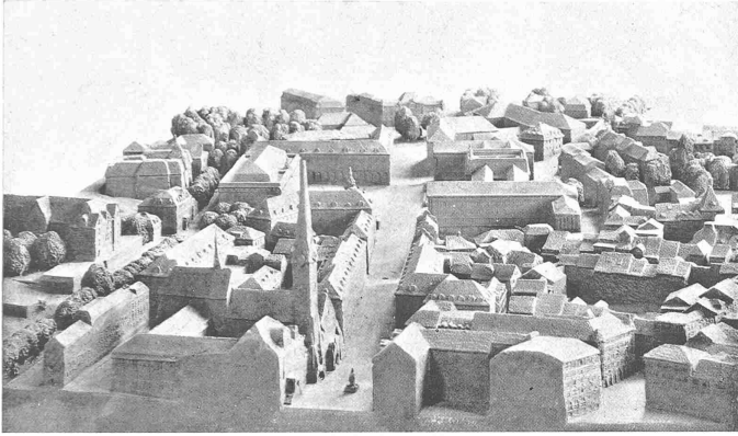
Blick aus N.-W., durch die Zähringerstrasse gegen den Heimplatz.
