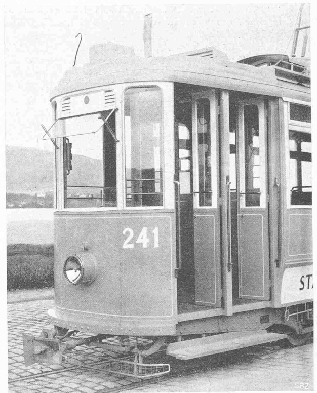
Abb. 6. Hinteres Motorwagen-Ende, Ein- und Ausstieg-Türen.
