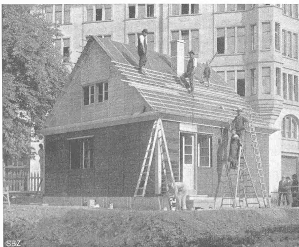
Abb. 21. Baufortschritt am 30. Juli 1919 nachmittags.
