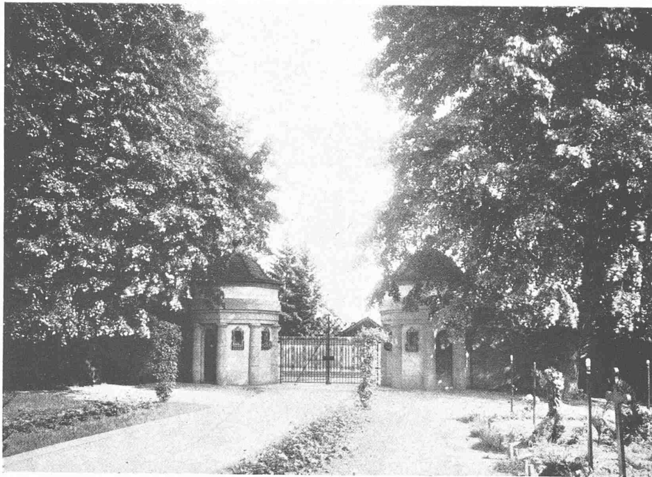
OBEN: NEUES FRIEDHOF-PORTAL VON INNEN
