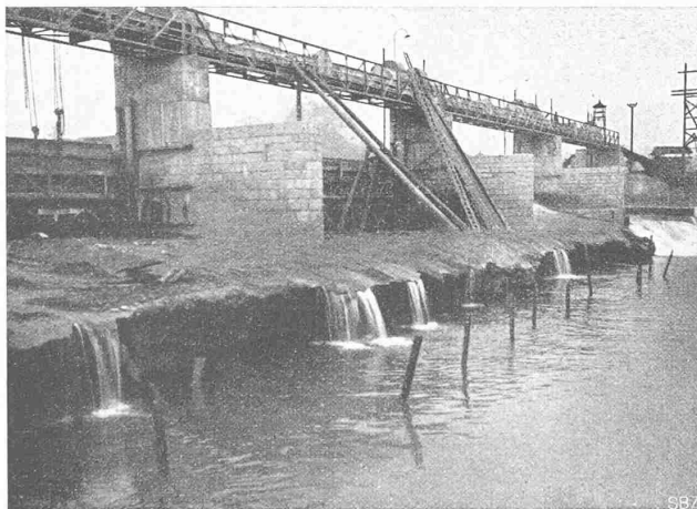
Abb. 10. Unterwassersseite eines Stauwehres bei Niederwasser.
