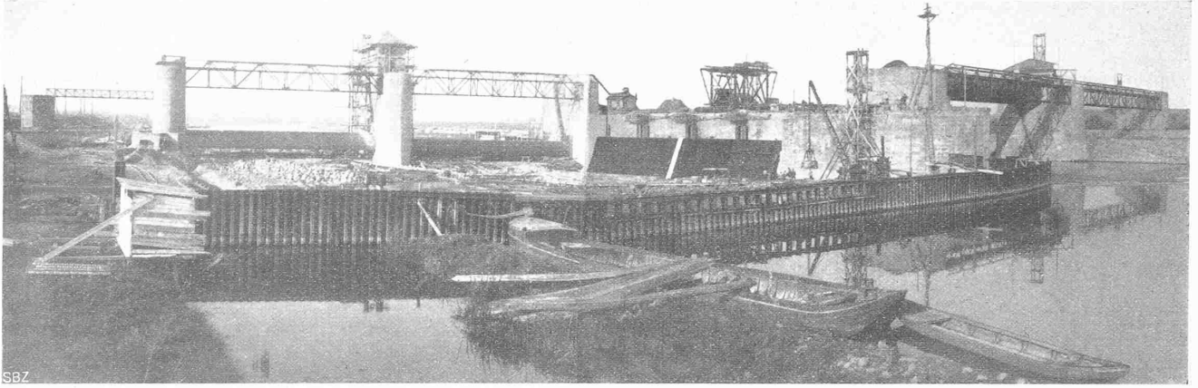
Abb. 4. Das Main-Kraftwerk bei Krotzenburg, von der Oberwasserseite gesehen, im Bau (Herbst 1918).
