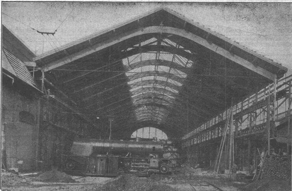
Montagehalle der Schweiz. Lokomotiv- und Maschinenfabrik Winterthur. Spannweite der Hetzerbinder 24½ m.
