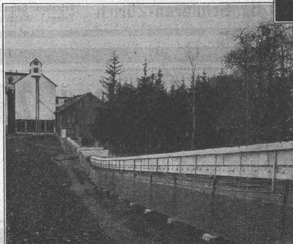
Transportanlage der Vereinigten Mühlen A.-G., Goldach mit Transportband von 200 Meter Länge.
