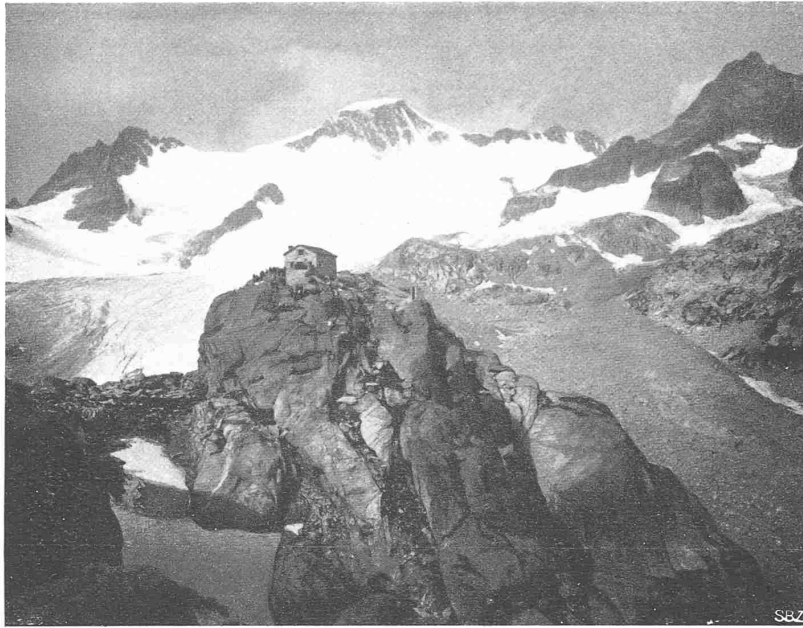
BLICK AUF DIE ALBERT HEIM-HÜTTE, GEGEN WESTEN GESEHEN IN DER MITTE DES HINTERGRUNDES DER GALENSTOCK UNTEN: DIE EINGANGSPARTIE
