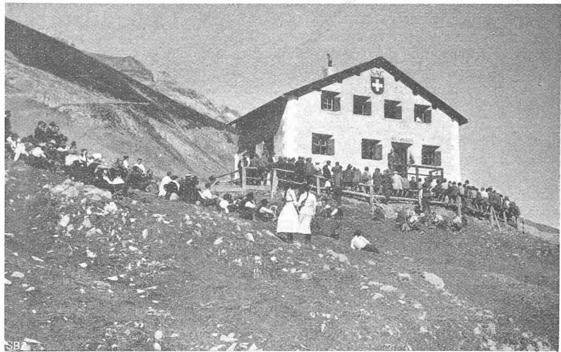
Abb. 6. Die Calanda-Hütte der Sektion Rhätia des S. A. C. — Arch. Schäfer & Risch, Chur.
