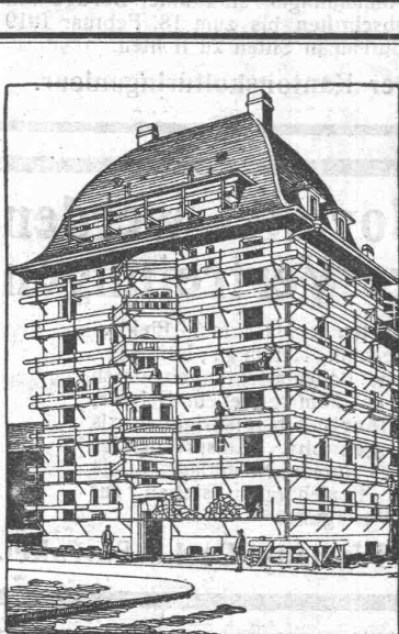
Ansicht eines eingerüsteten Hauses
