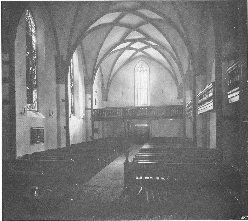
DIE RENOVATION DER ST. MARTINS-KIRCHE ZU CHUR
