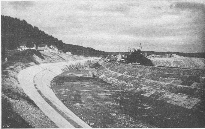
Uebergangstelle des Oberwasserkanals von dem Damm- in das Felsprofil hinter der Ruine Gösgen.
