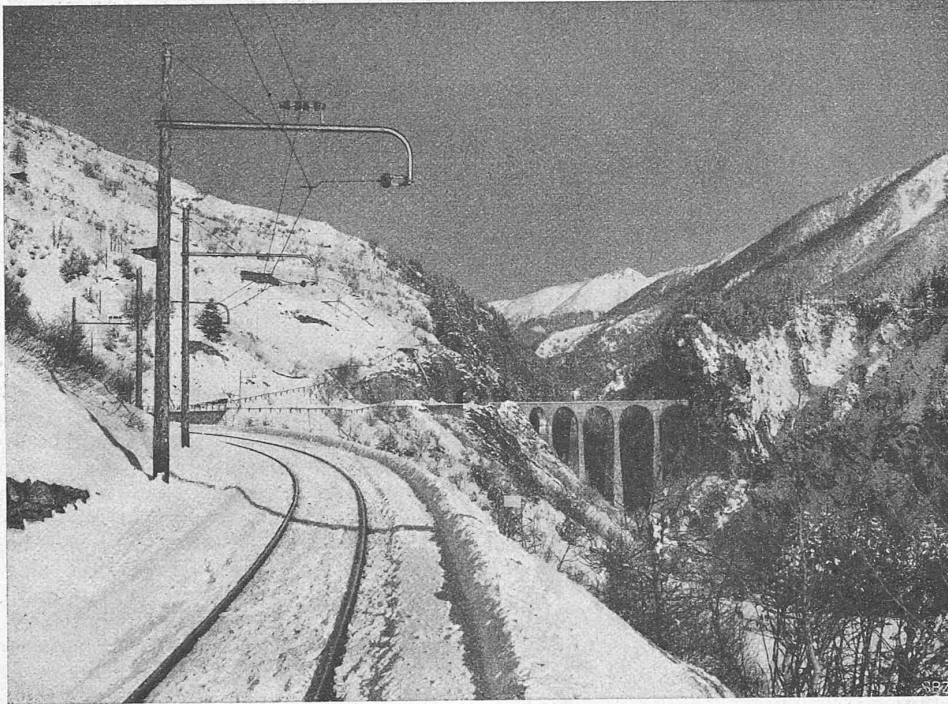
Abb. 18. Holzmasten mit gebogenem Abzug-Ausleger vor dem Landwasser-Viadukt.
