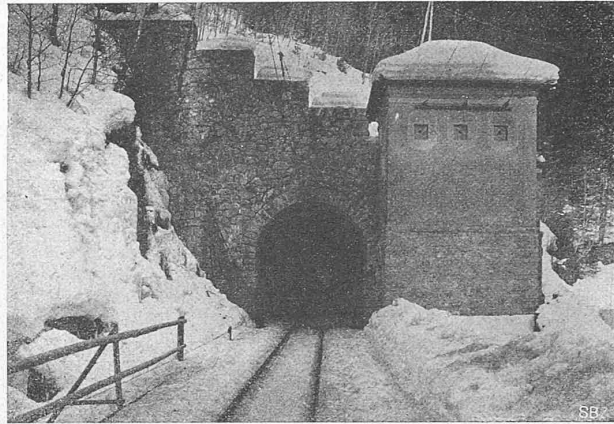
Abb. 15. Schalthäuschen vor dem Solis-Tunnel.
