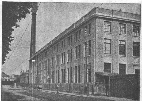
Nebenstehend: Werkstattneubau i. Eisenbeton d. HH. Gebr. Sulzer A.-G., Winterthur
