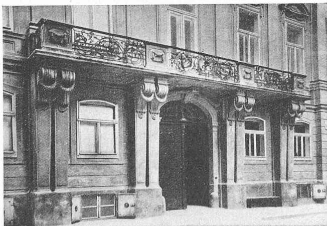
Abb. 4. Portal der Ungarischen Hofkanzlei in Wien.
