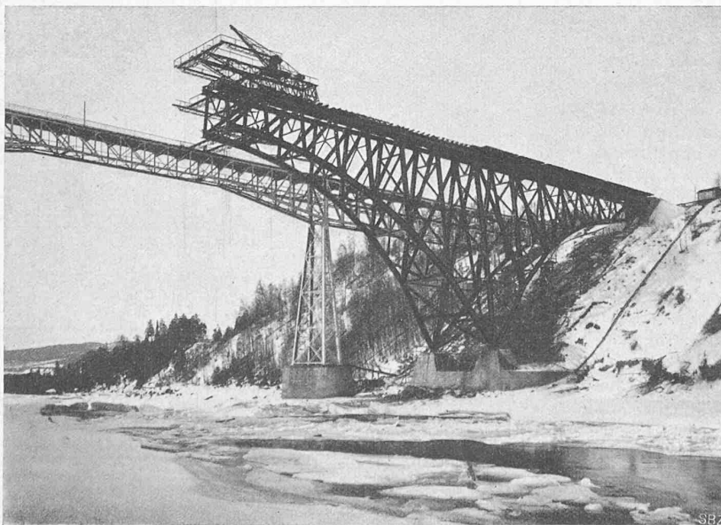
Abb. 17. Alte und neue Eisenbahnbrücke über den Angerman-Fluss bei Forsmo in Schweden.
