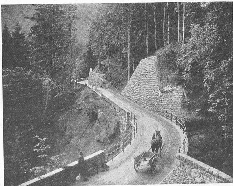
Abb. 13. Fertige Strasse bei Km. 1,35 bis 1,47 (vergl. oben Abb. 10 und 11).
