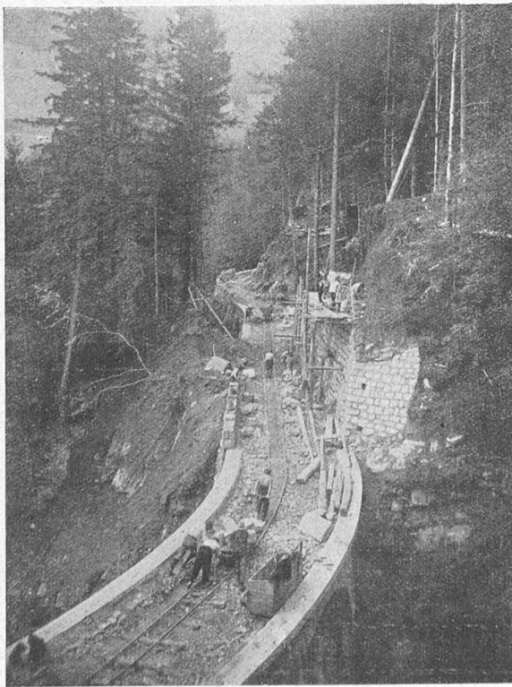
Abb. 12. Strecke Km. 1,35 bis 1,47 während des Baues.
