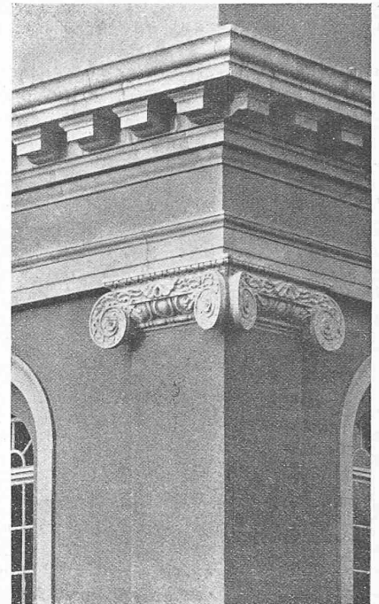
Abb. 16. Kapitell vom Eckpilaster.
